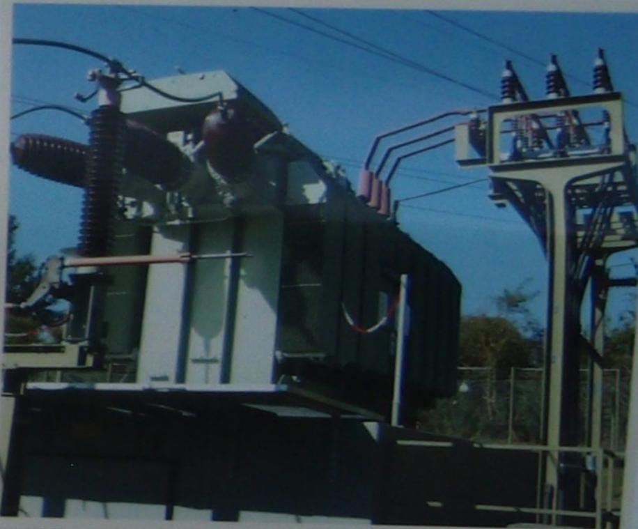
110 kV Einspeisung (links) und Abgang per Erdleitung in das 10 kV-Verteilnetz
